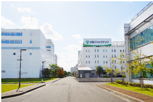
太陽ファルマテック高槻工場外観
